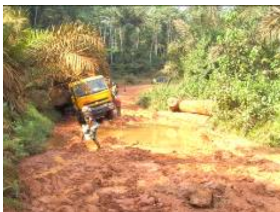
Photo 4 : Ouvrage de franchissement d'un affluent de la rivière Boumba sur la route départementale entre Zoulabot et Mpane Ditsiep
